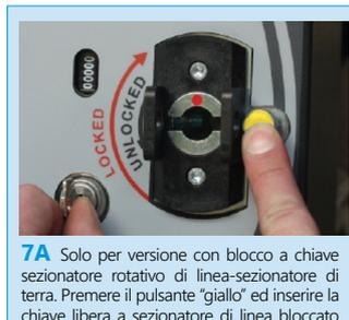
7A Solo per versione con blocco a chiave sezionatore rotativo di linea-sezionatore di terra. Premere il pulsante "giallo" ed inserire la chiave libera a sezionatore di linea bloccato in sezionato nel blocco a chiave ST in aperto.
